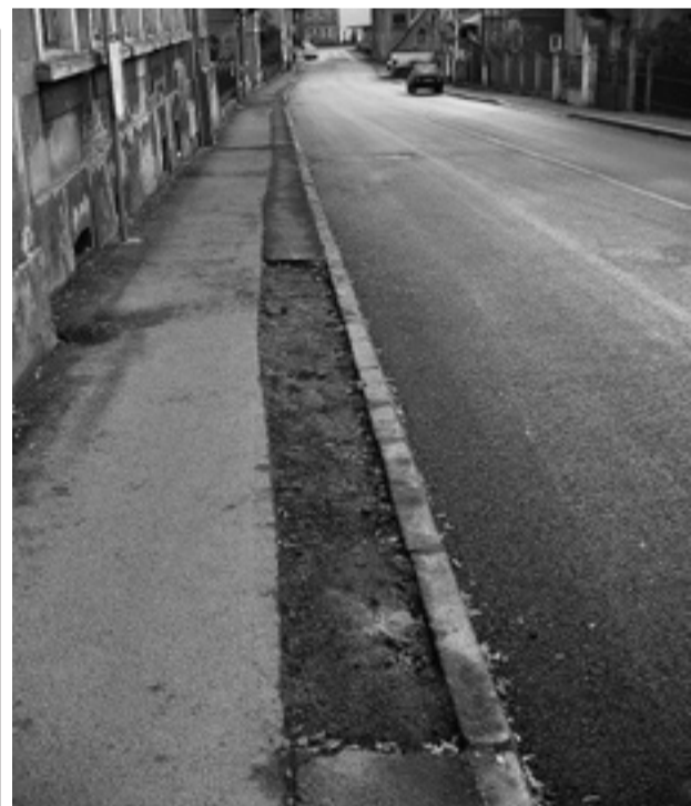
Ne všechno je po výkopěch v ulici 5. května v pořádku. Město si pohlídá, aby po odchodu firem opravdu bylo.
